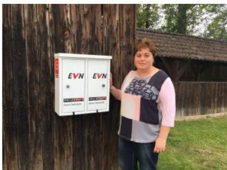
Das Aufladen ist bis zu 20 KW und zwei Autos gleichzeitig möglich. Der Stromanschluss ist eine Typ 2 Steckdose und zum Laden ist eine EVN Strom Tankkarte erforderlich. Außerdem gibt es zwei Ladeboxen für Akkus von E-Fahrrädern.
